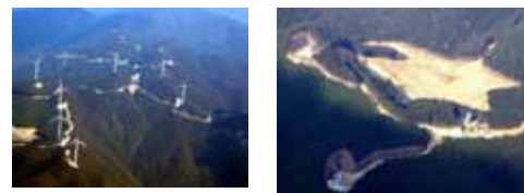
図2 尾根伝いに風力発電所の付設及び取付道路の建設による土地改変の例(A風力発電所):A風力発電所に関するホームページ
