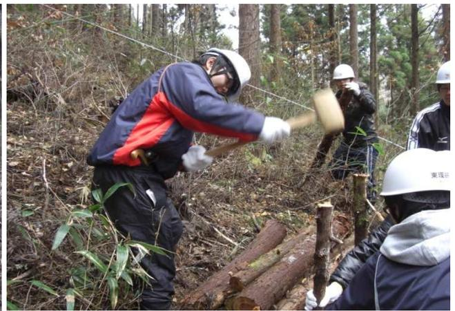
積雪による影響を考え、急斜面に隠れ家を設置する場合は先に木杭をしっかり打ってから丸太を積み上げます。屋根は太めの枝を選んで載せました。
