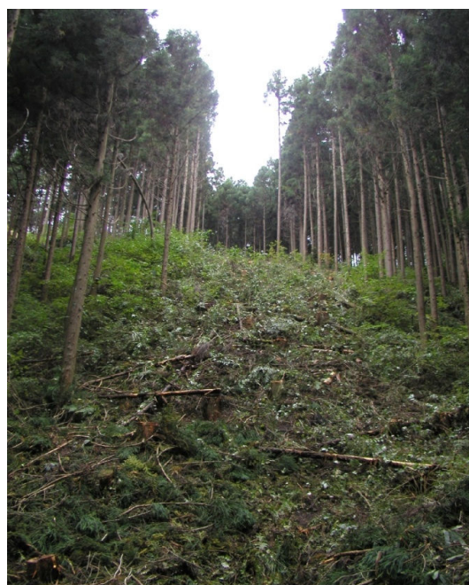
伐採幅9メートル 残し幅21メートル
