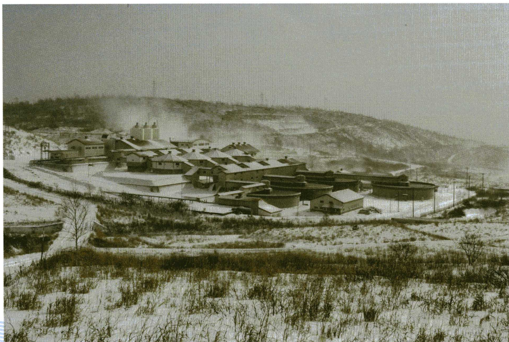
厳冬期の新中和処理施設
